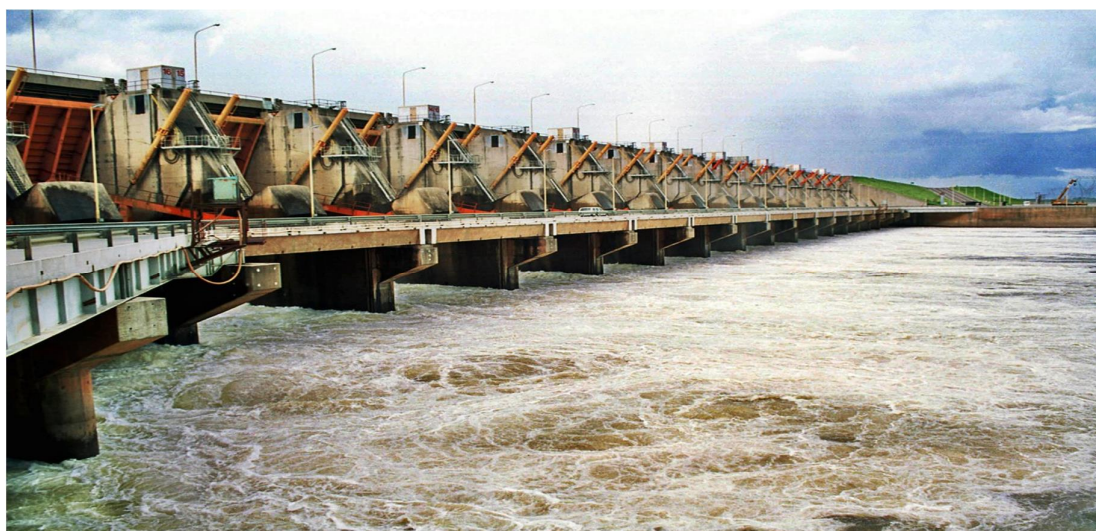
Ilustración 1 . Central Hidroeléctrica Yasyretá
